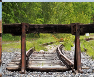
MĚNĚ NA NOVÉ ŽELEZNICE
